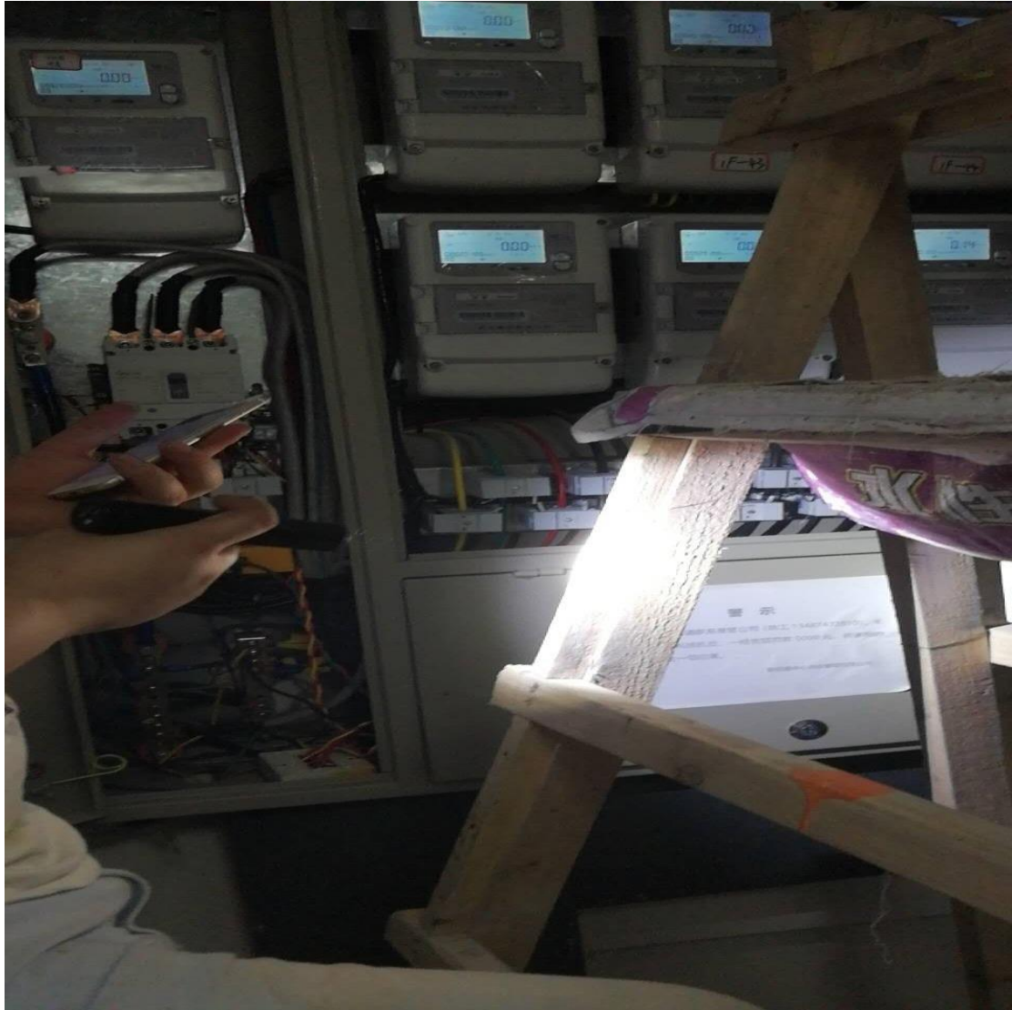
（施工现场调试实拍）
